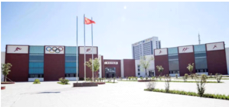
图 1 图 1-1: 营口市体育运动学校综合训练馆
